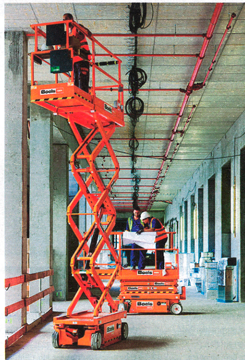
Ausbau nach Plan Im ersten Stock wird bereits die Elektrik installiert. Die großzügige Raumhöhe bleibt
