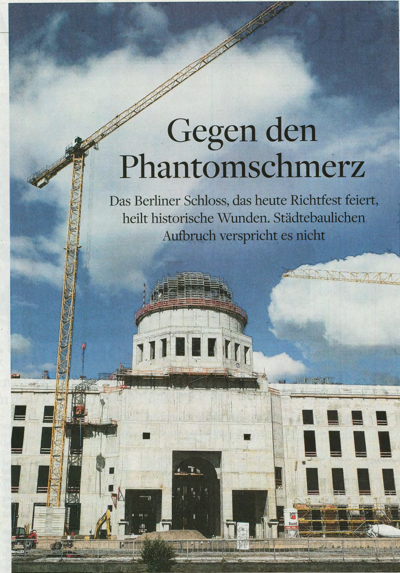
Will einmal ein Schloss werden: Dem Rohbau des Humboldtforums wird heute die Richtkrone aufgesetzt
